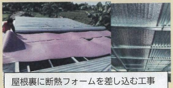
屋根裏に断熱フォームを差し込む工事
